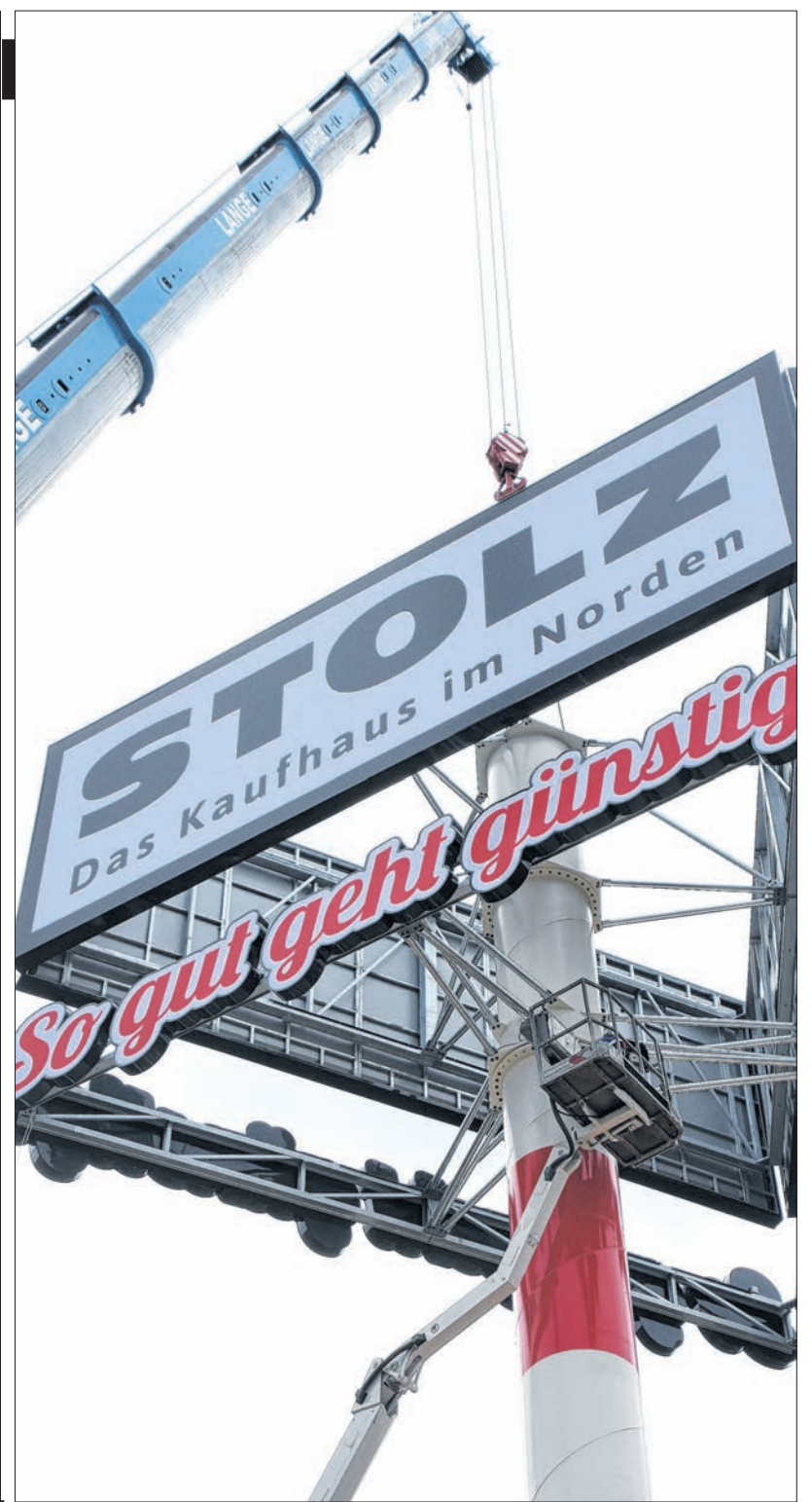
Dieser 30 Meter hohe Werbeaufsteller soll mehr Kunden zum Pommerndreieck locken. Eine Münchner Firma hat ihn konzipiert und auch die Montage überwacht. Foto: Reinhard Amler
